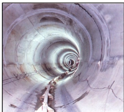
Canalisation ( \varnothing = 4,5 \text{ m} )
